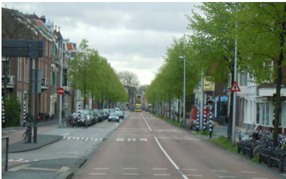
Busskörfält i Utrecht – biltrafiken fick det som blev över – ett körfält samt parkering. Gupp för bilar, inte för bussen.
