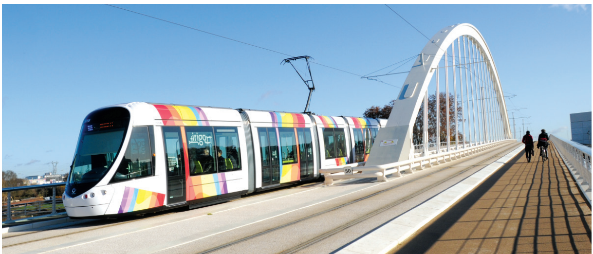
Vid nybyggnad av spårväg krävs ibland ny infrastruktur som denna bro i Angers för enbart spårväg och gång och cykel
