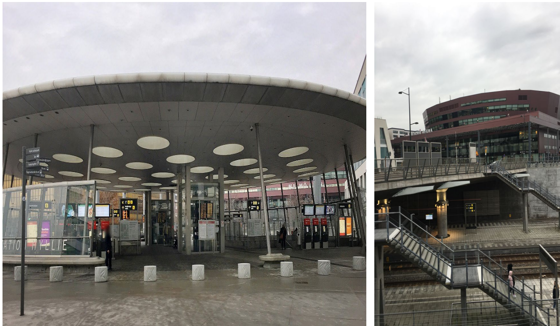
Figur 8. Visar Hyllie station ovan mark samt trapporna ner till plattformen. Foto: Sofia Rutberg.
