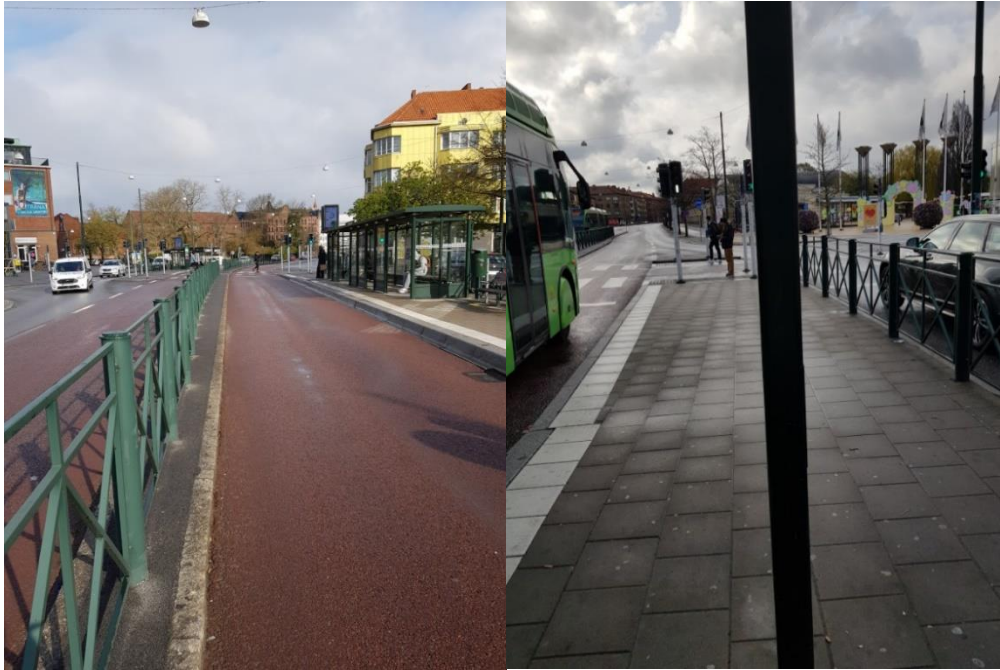
Figur 31. Hållplats Folkets park. Till vänster: den identiska utformning som finns i de båda riktningarna och till höger: en kollektivtrafiksignal vid utkörning.
