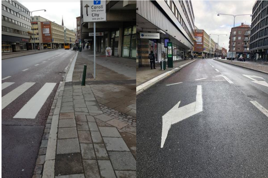
Figur 29. Hållplats Studentgatan. Till vänster: väjning och övergångsställe vid utkörning mot Västra hamnen och till höger: övergångsställe vid utkörning (där fotografen står) mot Stenkällan.
