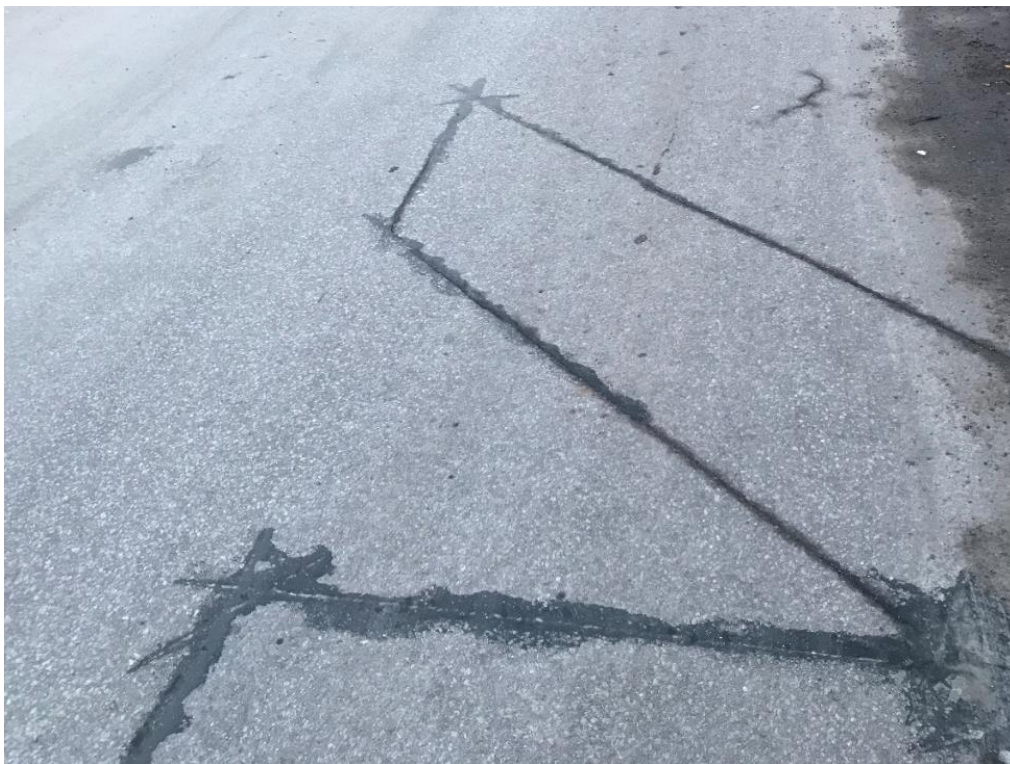
Figur 11. Spår efter placering av en induktiv slinga under asfalten i anslutning till en korsning.
