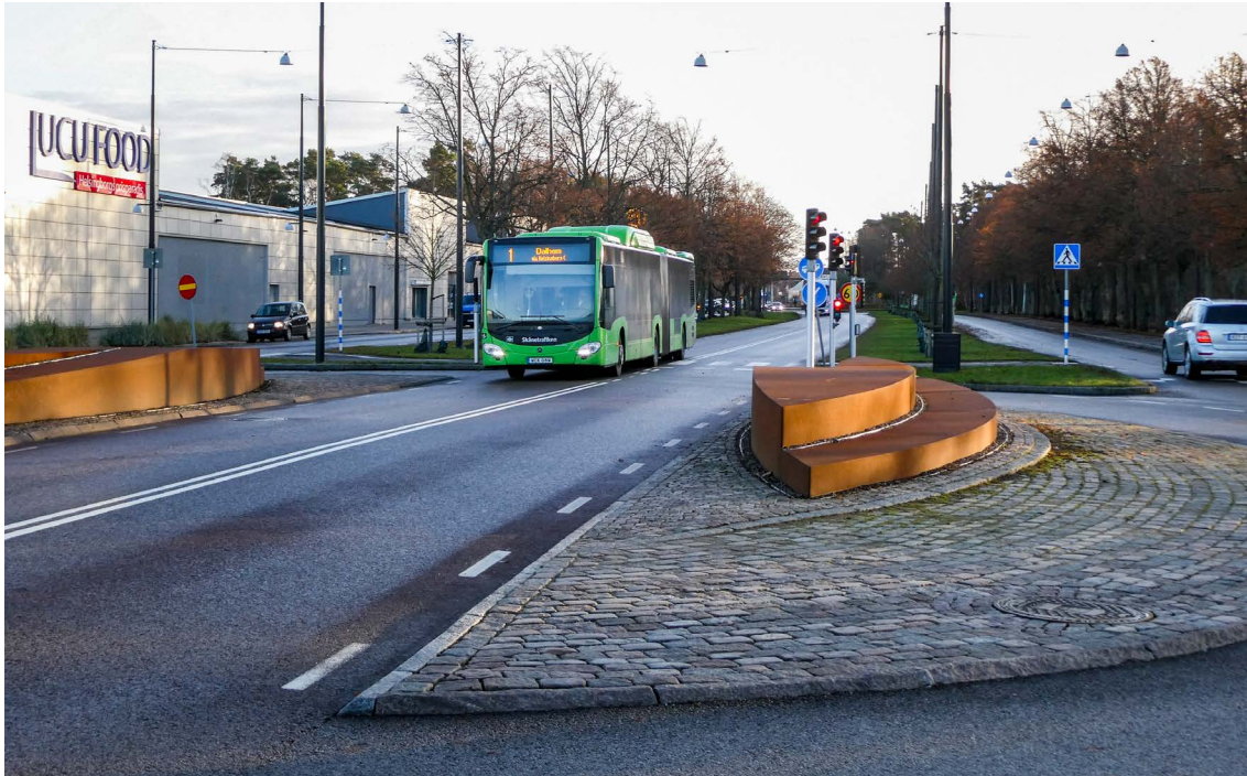
3) Rakt och gent i Helsingborg: Bussgatan löper rakt genom cirkulationsplatsen och undviker därmed tre tvära kurvor – vid infart, inne i cirkulationsplatsen och vid utfart. Bild: PG Andersson, Trivector.
