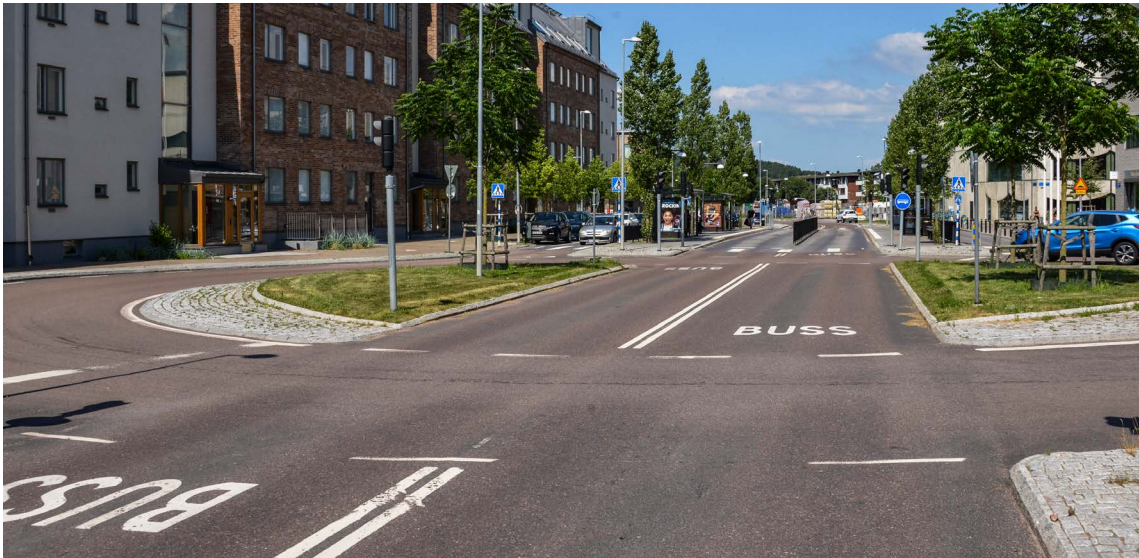
14:1) Litteraturgatan i Göteborg. Buskörfälten löper rakt genom den signalreglerade cirkulationsplatsen, vilket innebär att ingen korsande trafik förekommer när bussen passerar. Bild: PG Andersson, Trivector.
