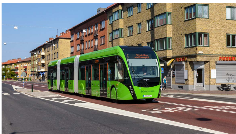
7:3) Visuellt markerade busskörfält genom rödfärgad asfalt på Amiralsgatan i Malmö. Bild: PG Andersson, Trivector.
