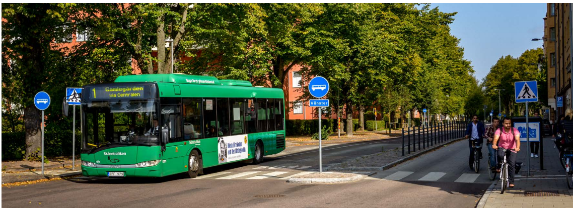
11) Södra Kaserngatan i Kristianstad före och efter utbyggnaden av Kristianstadslänken. Bussens körväg kantades tidigare av gatuparkering på bägge sidor, men nu kör bussarna helt separerade från övrig trafik. Nedre bild: PG Andersson, Trivector.
