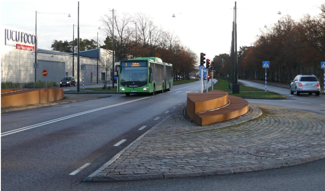
Figur 3. Rakt och gent i Helsingborg: Bussgatan löper rakt genom cirkulationsplatsen och undviker därmed tre tvära kurvor – vid infart, inne i cirkulationsplatsen och vid utfart. Bild: PG Andersson, Trivector.
