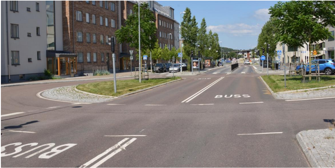
Figur 14:1. Litteraturgatan i Göteborg. Busskörfälten löper rakt genom den signalreglerade cirkulationsplatsen, vilket innebär att ingen korsande trafik förekommer när bussen passerar. Bild: PG Andersson, Trivector.
