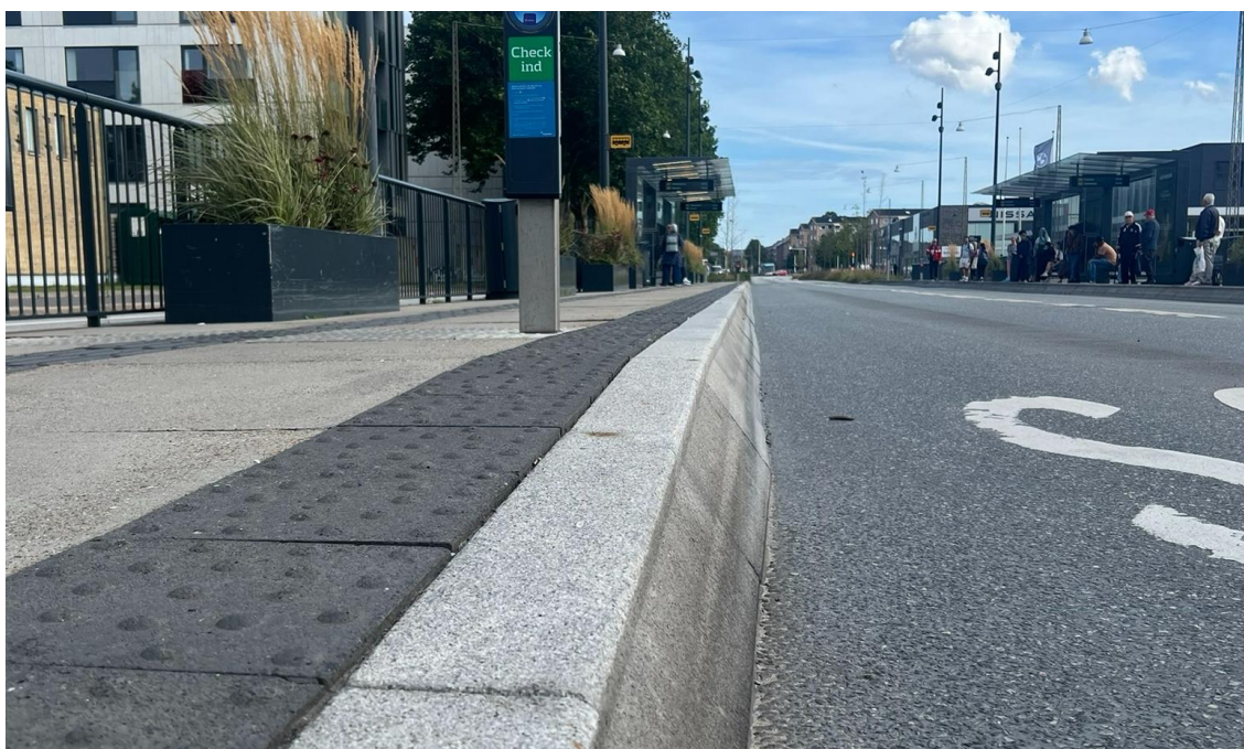
Figur 15. Utmed linje 2 i Aalborg har hållplatserna 24 centimeter höga plattformar för att åstadkomma plant insteg utan bussnigning. Även perrongutvidgning tillämpas. Bussgatan är därmed något smalare vid hållplatserna än på sträckorna däremellan.
