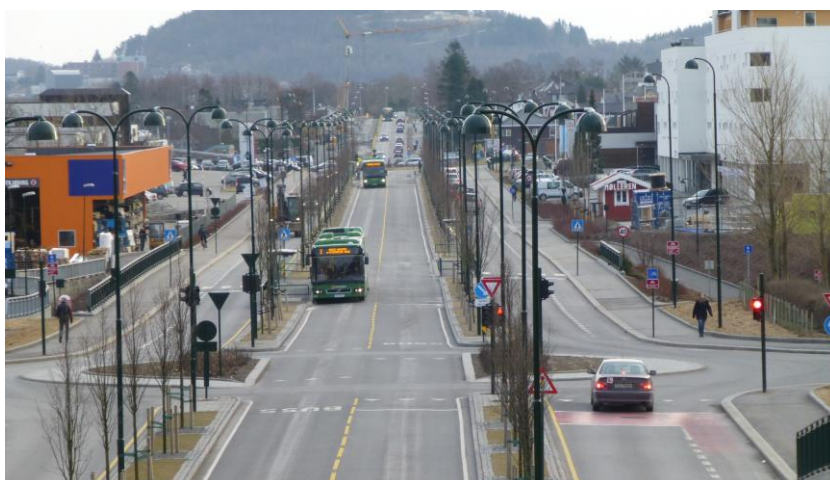
Figur 7:1. Fysisk separering av busskörfälten med hjälp av refuger med träd i Stavanger, Norge. Bild: PG Andersson, Trivector.
